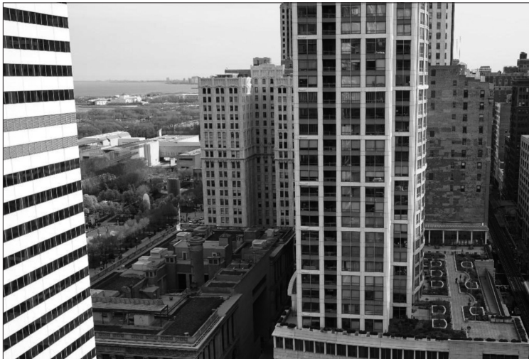
Selon les critères de la mairie de Chicago, le toit du Chicago Cultural Center (à gauche) est un green roof et le jardin du Condominium Heritage at Millenium (à droite) un garden roof . Néanmoins, ce jardin est appelé terrace garden dans les annonces immobilières concernant le condominium . (Photographie : Marion Messador, avril 2015)
