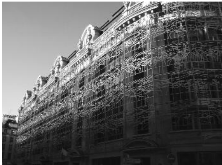
Ancien immeuble des Bons-Enfants, Paris I er , siège de la direction de l'Architecture et du Patrimoine (crédit photo DAPA).
